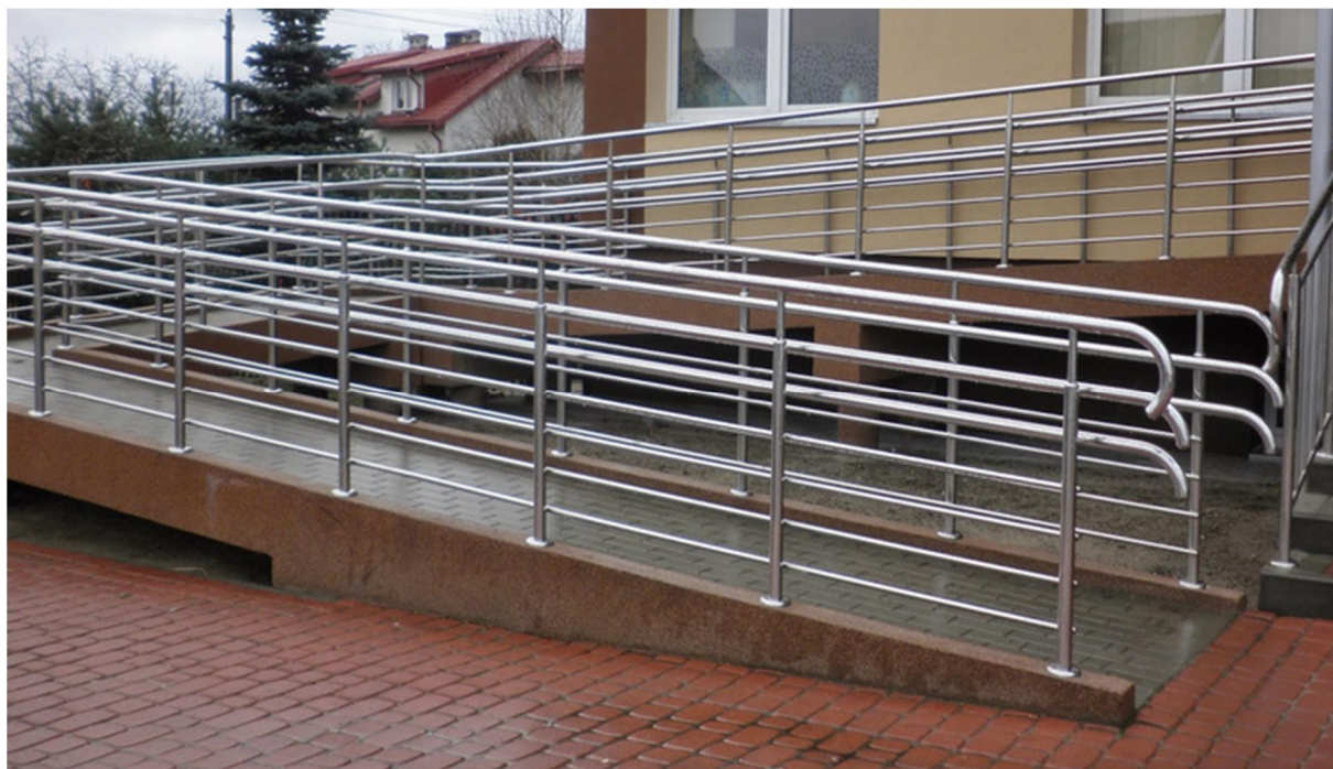
Schemat balustrady – wypełnienie przestrzeni między słupkami
